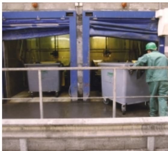
Lavage automatique des GRV.
